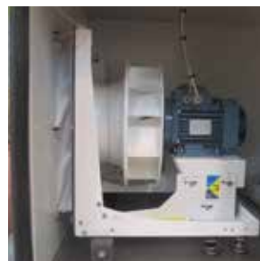
Roue libre avec moteur asynchrone
